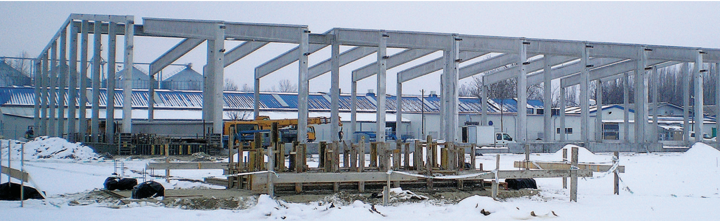
A Szentkirályi Ásványvíz telephelyén az építkezés a zord időjárás ellenére is megfelelő ütemben halad, a tervezett átadás május végén várható
